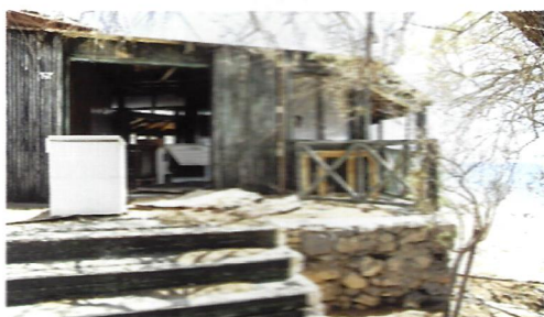
Μεταβολή αγραλού και αυθαίρετη δόμηση σε προστατευόμενη περιοχή του δικτύου Natura 2000. Νήος Ντία. (Φωτ. ΜΦΙΚ).
